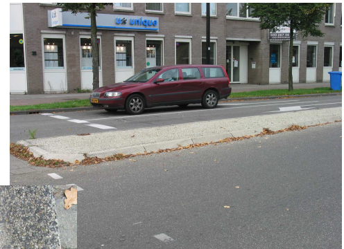
Links: elementverharding met voegvulling
