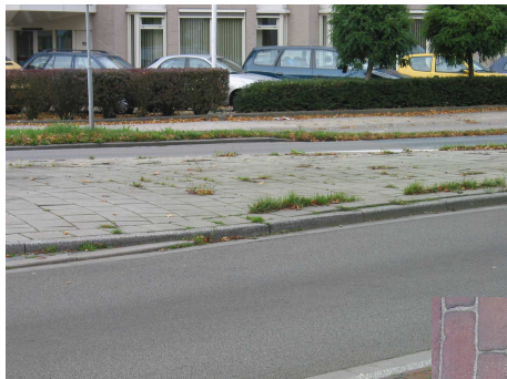
Boven: een verkeersgeleider met elementverharding
