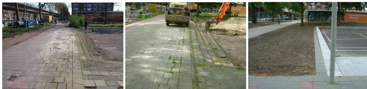
Figuur 1. Voorbeeld van preventieve onkruidbestrijding door verwijdering van onnodig brede en verzakte bestrating (Foto's: Roteb, Rotterdam).
